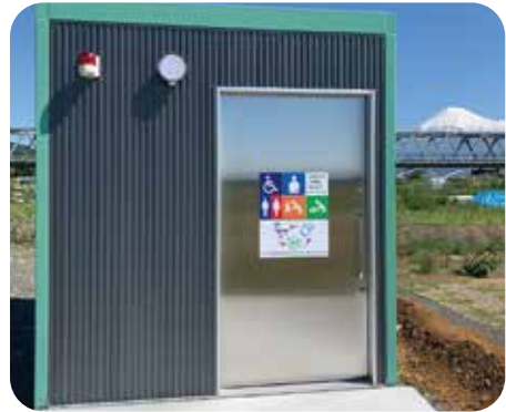
富士川河川敷トイレ
